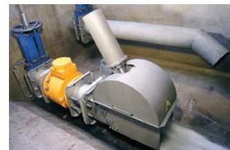
Clona s váhou s ovládacím modulem
