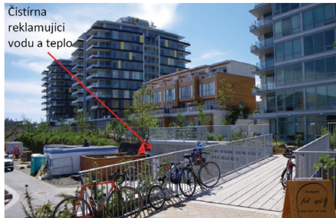
Obr. 5. Moderní čistírna použité vody s obnovou zdrojů (resource recovery) v udržitelné čtvrti Docksider Green ve Viktorii (BC) v Kanadě, která znovuzískává teplo teplotními čerpadly a čistou vodu z použité vody pro několik druhů spotřeb ve čtvrti. Foto W. P. Lucey, AquaTex Scientific Consulting, Victoria
