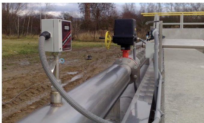
Obrázek č. 2 – aplikace termického hmotnostního průtokoměru na ČOV
