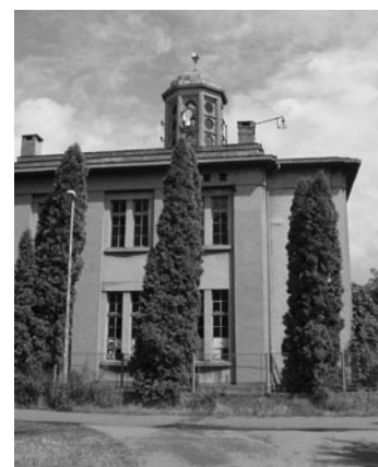
Provozní budova elektrárny s kubistickou věžičkou
