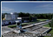
Rekonstrukce ČOV Humpolec (28 500 €)
