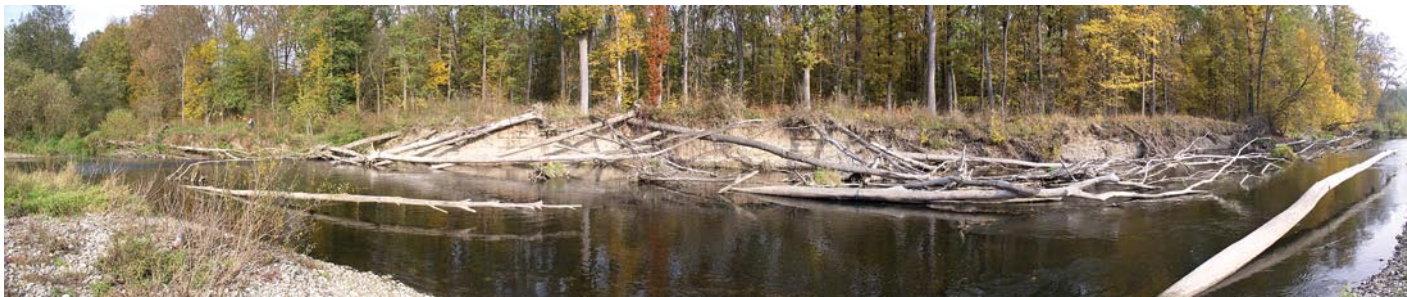
Obr. 2. Panoramatický snímek meandru M4. Kmeny v blízkosti nárazového břehu byly vyvráceny a korunou orientovány do koryta. Na tomto snímku z října 2006 mají kmeny téměř totožnou polohu jako při ukotvení v roce 2003. Kmeny v popředí a uprostřed koryta jsou na lokalitě původní a nebyly předmětem stabilizace (foto: P. Kožený)
