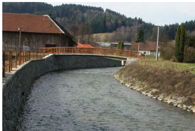
Dlouhá Třebová, nová lávka
