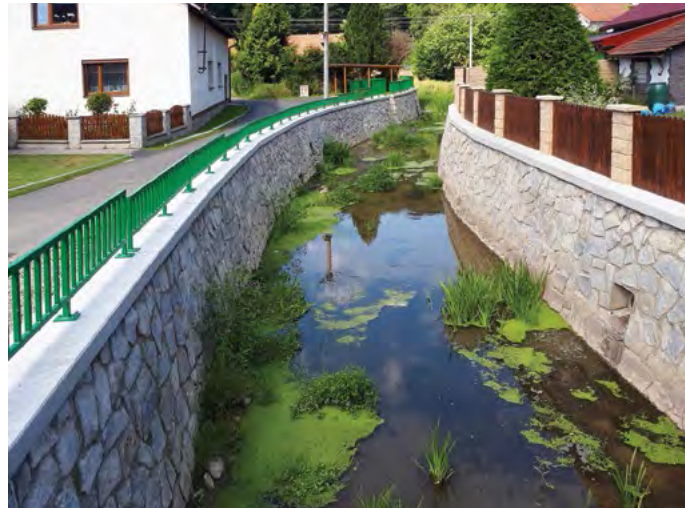
Třebovice, nové nábrežní zdi
