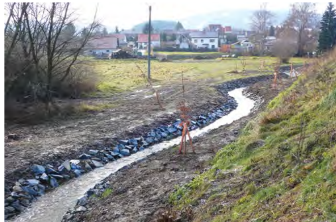
Obr. 3. Rozpačitá přestavba potoka sice naplňuje „revitalizační minimum“ odstranění technického opevnění, ale o mnoho dál už nedošla, přestože nejspíš mohla. Nevýrazné zvlnění „melioráku“ přináší jen skromné posílení tvarové členitosti, pro hydraulickou členitost se neudělalo prakticky nic, koryto je stejně hluboké a kapacitní, jako dříve, posílení akumulace vody v korytě a v nivě tedy prakticky nenastalo. Kameny by mnohem lépe posloužily v podobě dnových příčných pasů, než takto naskládány do břehů koryta. Na kraji obce sice nebyly podmínky pro plně rozvinuté přírodně autentické pojednání potoka, ale i tady se dalo udělat o dost víc
