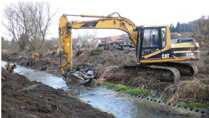
Obr. 4. Bagr právě v technicky upraveném korytě naplňuje „revitalizační minimum“ – odstraňuje opevnění polovegetačními tvárnicemi. Revitalizace Říčanky na dolním okraji Říčan, akce Povodí Vltavy, s.p., 2015
