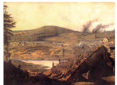
Veduta výstavby nádrže
