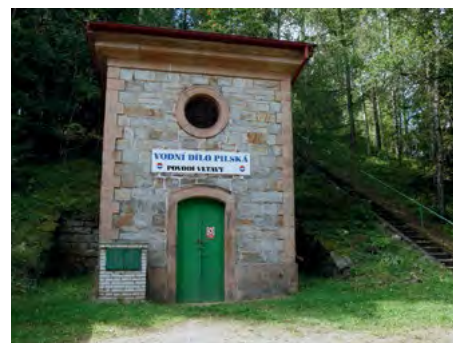
Vstup do štoly
