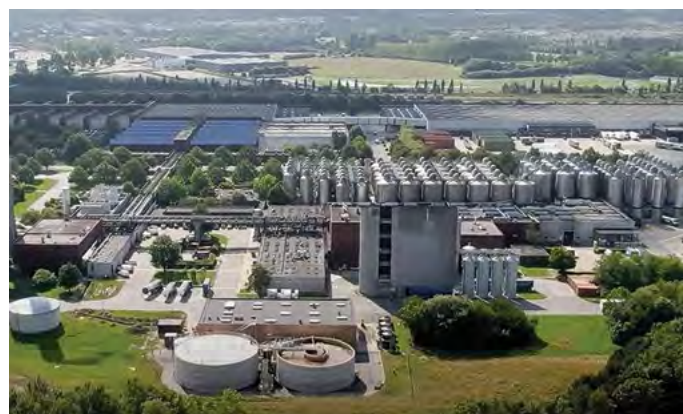
Obr. 1. Celkový pohled na pivovar Carlsberg ve Fredericii, recyklační úprava vody v popředí se skládá z čistírenské části, úplně vpředu, a vodárenské části v hale vedle obou válcových nádrží [1]
