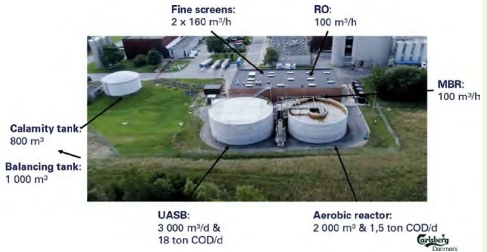
Obr. 4. Umístění jednotlivých procesů v recyklační úpravně. Fine screens – jemná síta, Calamity tank – havarijní nádrž, Balancing tank – vyrovnávací nádrž, UASB – (Upflow Anaerobic Sludge Blanket) – metan produkující vyhnívací zařízení, Aerobic reactor – aerobní reaktor, MBR – membránový bioreaktor, RO – reverzní osmóza.
