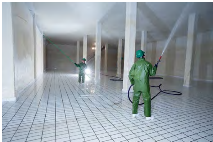
Čištění vodojemu pracovníky CARELA®
