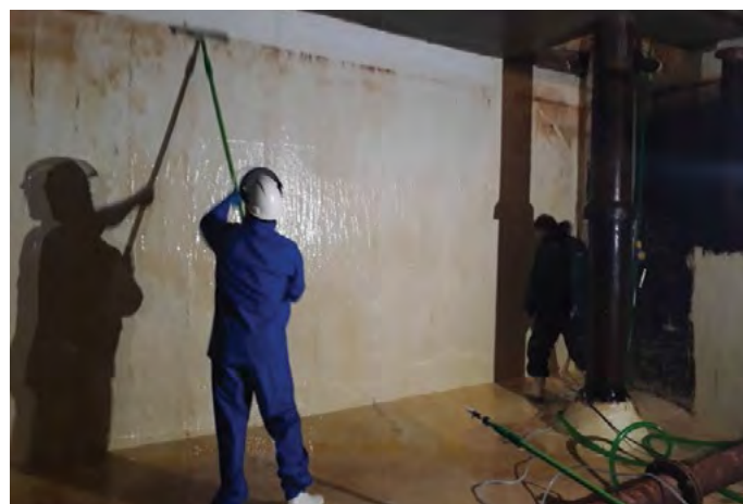
Dočištění stěny vodojemu
