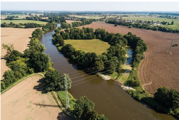
Revitalizované rameno po dokončení
