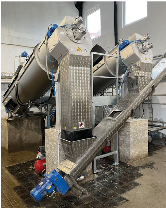
Instalace odvodňovacích linek v JIP-Papírny Větrní, a.s.
