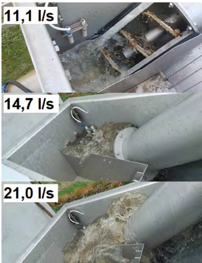
Obr. 5. Převáděné průtoky při funkčním hladinovém spínání
