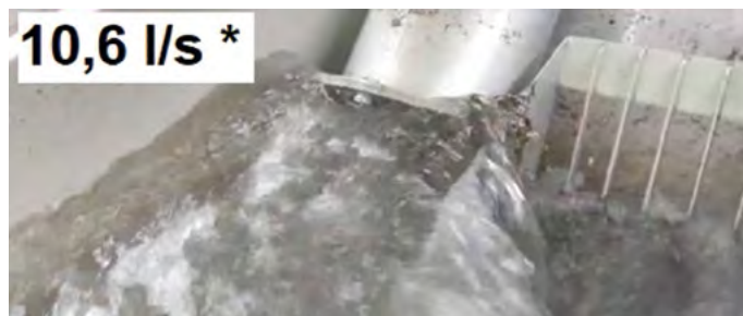
Obr. 6. Q 10,6 l/s při zanesené hladinové sondě
