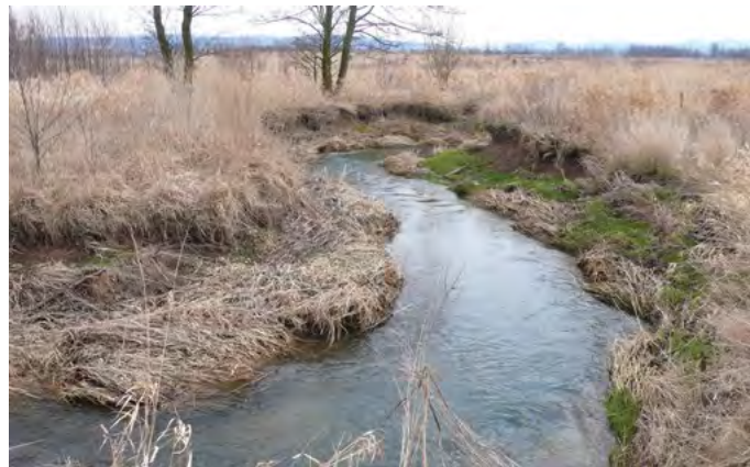
Vývoj Lukovského potoka počátkem roku 2014, asi osm let po výstavbě. Terén okolo koryta plně obsadily traviny hned po dokončení výstavby. Břehy koryta jsou strmé, stále se sesouvají i s drnovým pokryvem. Semena nebo zakořenitelné části dřevin v tomto prostředí neuspívají
