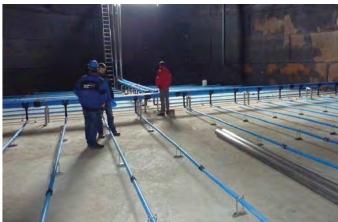
Obr. 3. Aerační systém MBBR reaktoru
