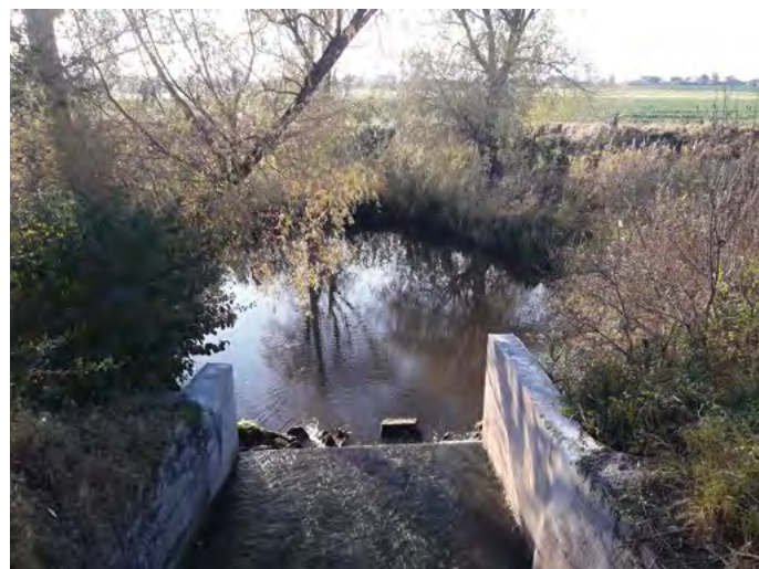
Obr. 4. Skluz bezpečnostního přelivu s mohutným vývařištěm
