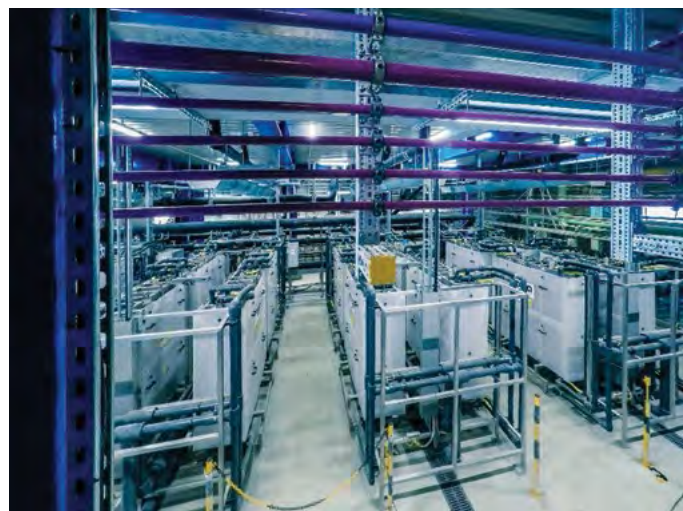
Obr. 2. EDR s kapacitou přes 640 m 3 /h
