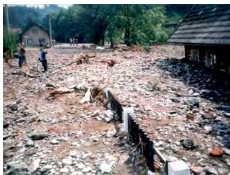
Zástavba v obci Dobré po průchodu povodňové vlny
