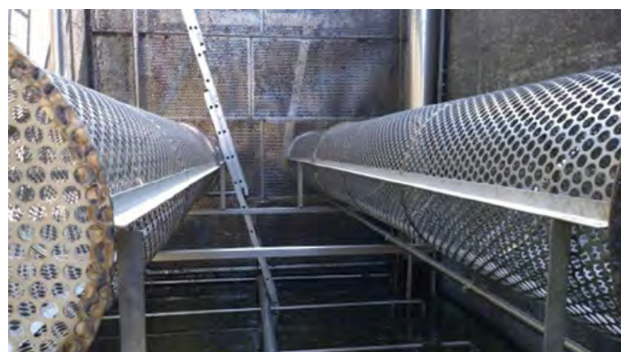
Obr. 5. Odtoková síta MBBR reaktoru pro zadržování nosičů
