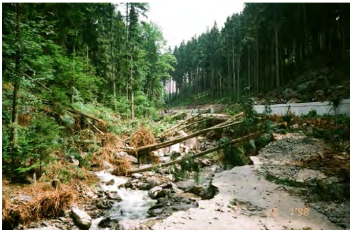
Destrukce koryta vodního toku a souběžné komunikace nad obcí Kounov směr Deštné v O. h.
