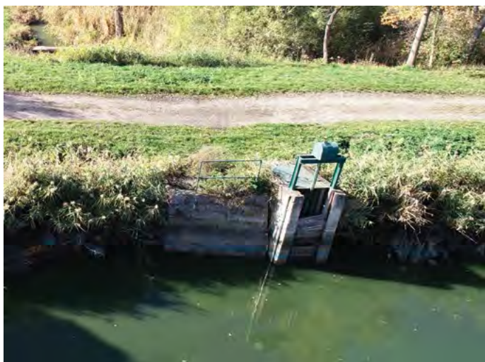
Obr. 3. Šachta uzavřeného požeráku na spodní výpusti rybníka Mrštín
