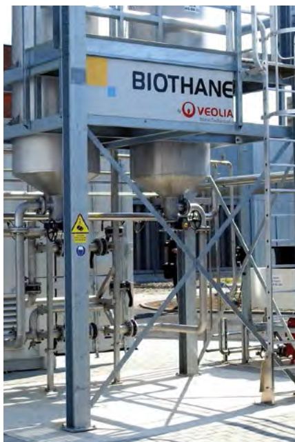
K úpravě bioplynu na bioCNG slouží jednotka využívající membránovou technologii MemGas TM skupiny Veolia.
