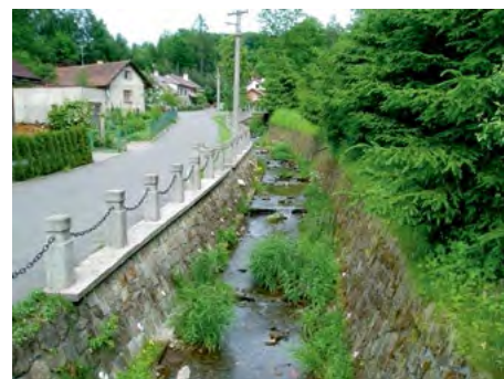
Rekonstruované koryto toku v obci Dobré
