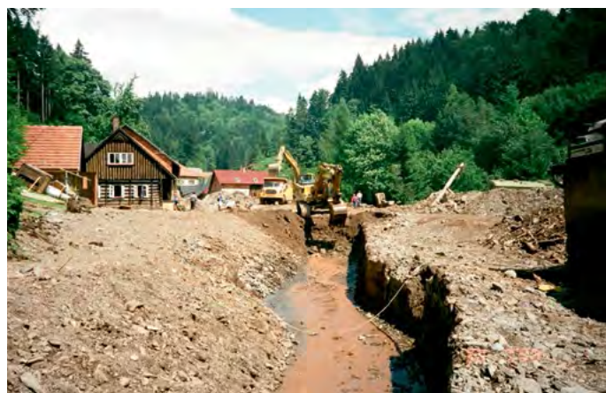
Provádění zabezpečovacích prací – zajištění průtočnosti koryta vodního toku – v obci Kounov
