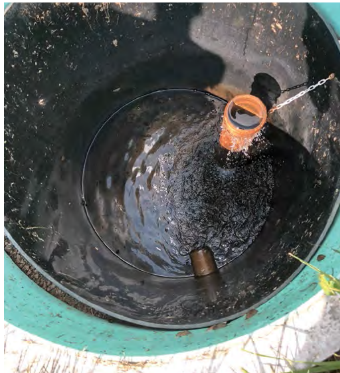
Odtok z kořenové ČOV Velká Jesenice
