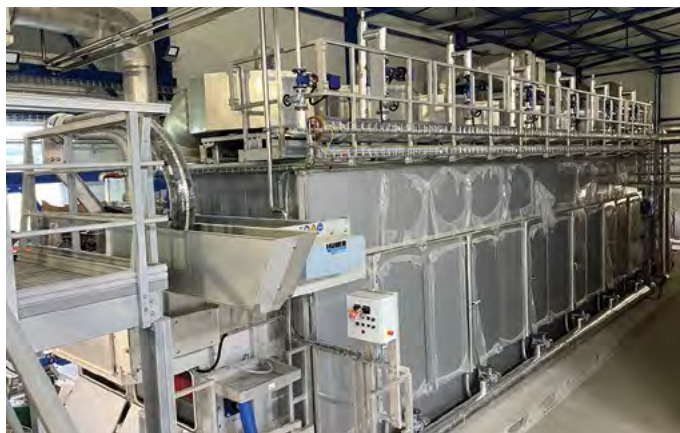
Obr. 1. ČOV Šumperk – z výstavby sušárny kalu
